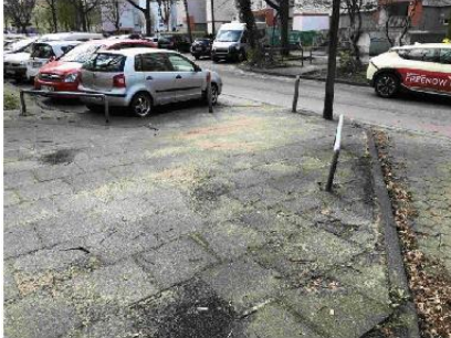
Geländer, Pfosten, Querungsstelle schräg
